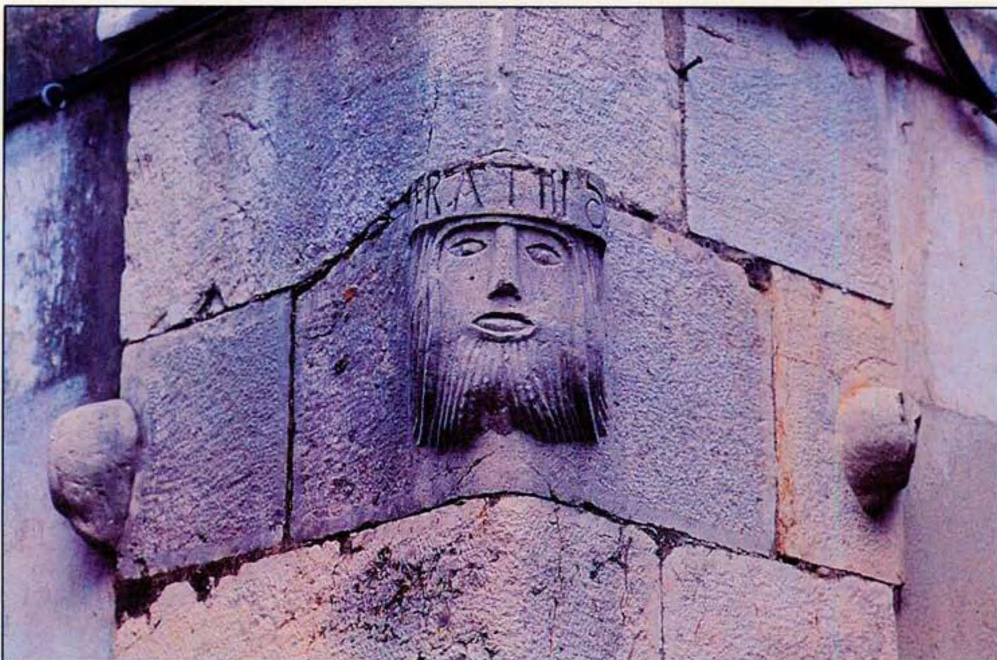
Cunhal do edificio sito na Rua Direita, nº 44 – Setúbal
