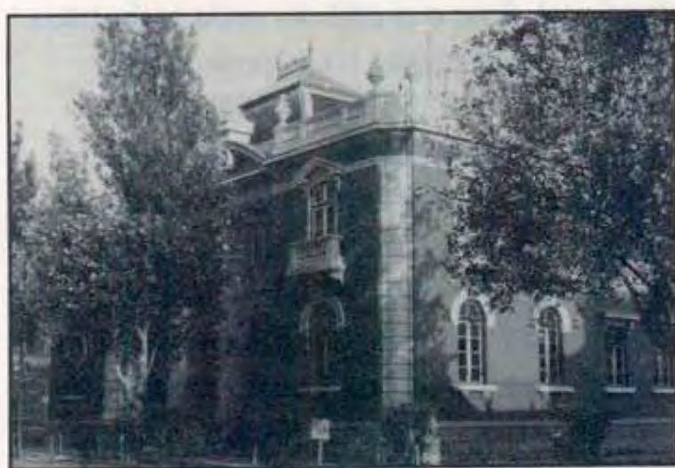
Fig. 19 – Aspecto da fachada principal da agência do Banco de Portugal. Av. Luisa Todi. Foto de J. Soares. 1986.
