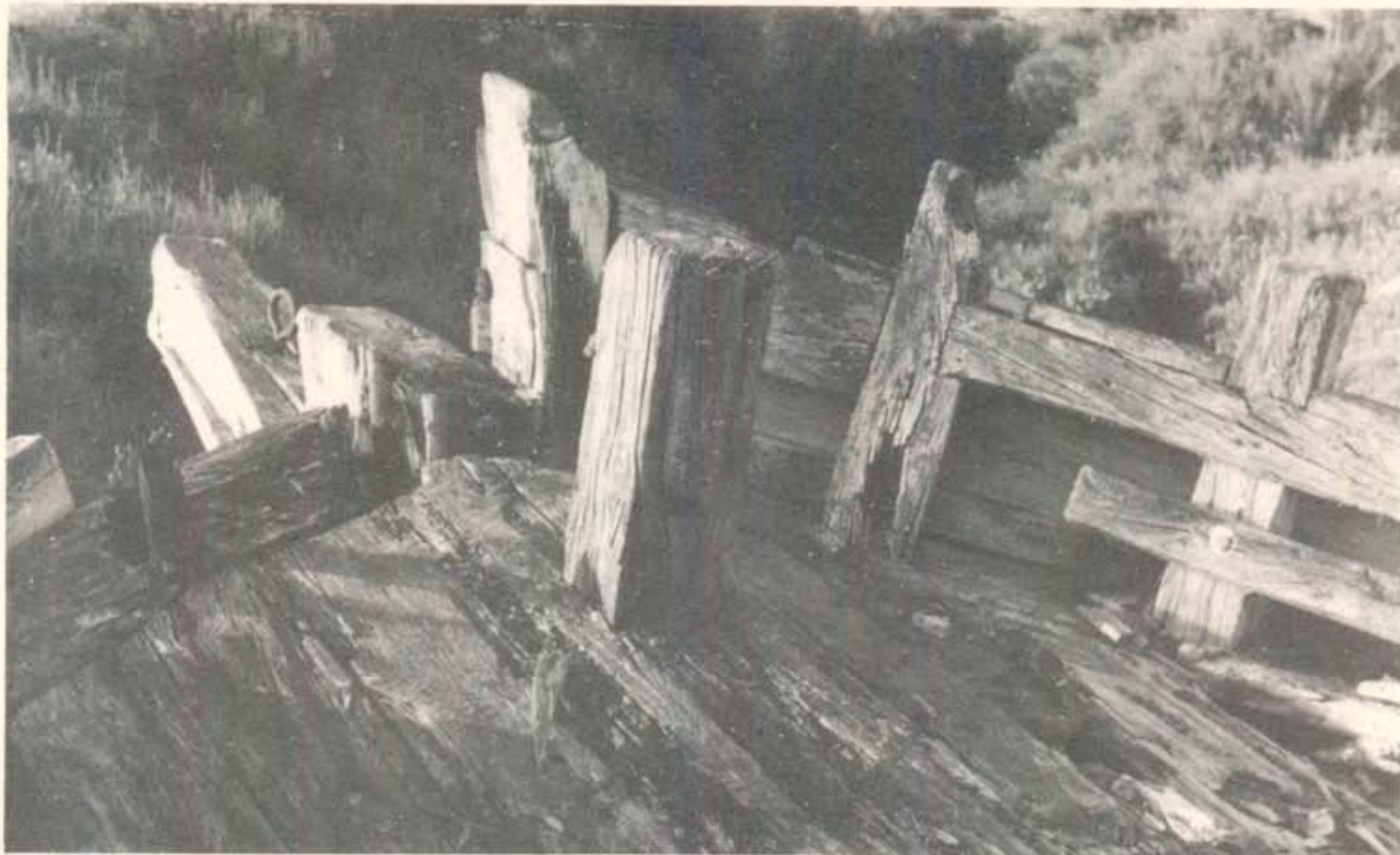
Fig. 13 — Hiate Sto. António. Pormenor da vante, deixando perceber o avançado estado de deterioração da madeira.
