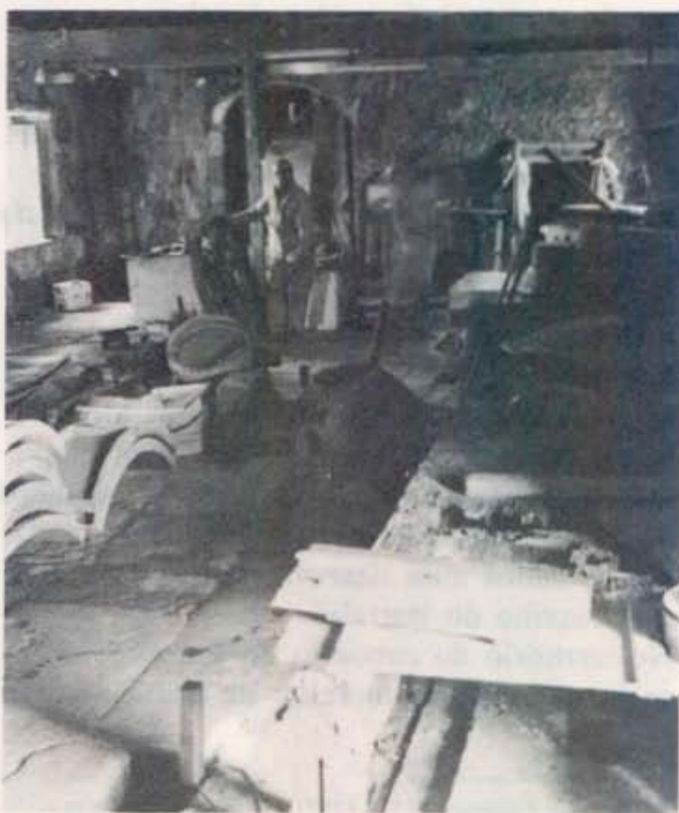
INTERIOR DO MOINHO DE CORROIOS A SER RECUPERADO
