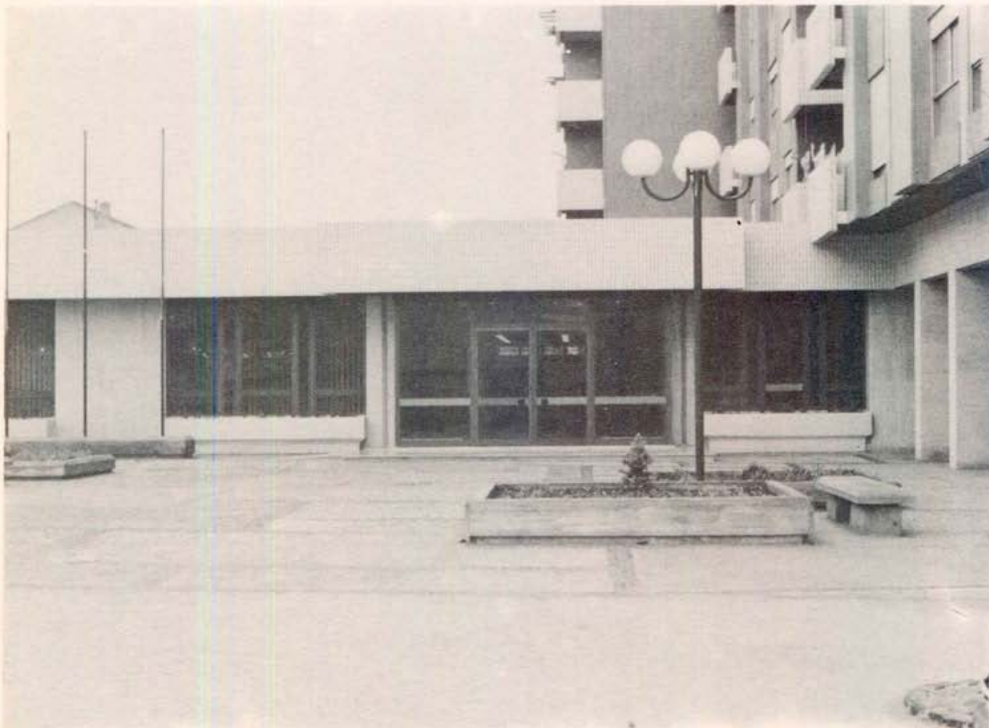
ESPAÇOS ENVOLVENTES E ENTRADA PRINCIPAL DA BIBLIOTECA MUNICIPAL.
