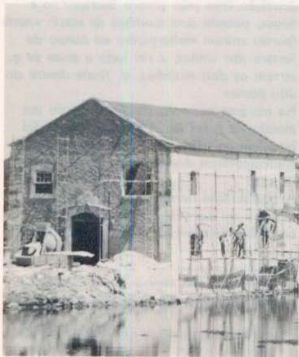
MOINHO DE CORROIOS A SER RESTAURADO
