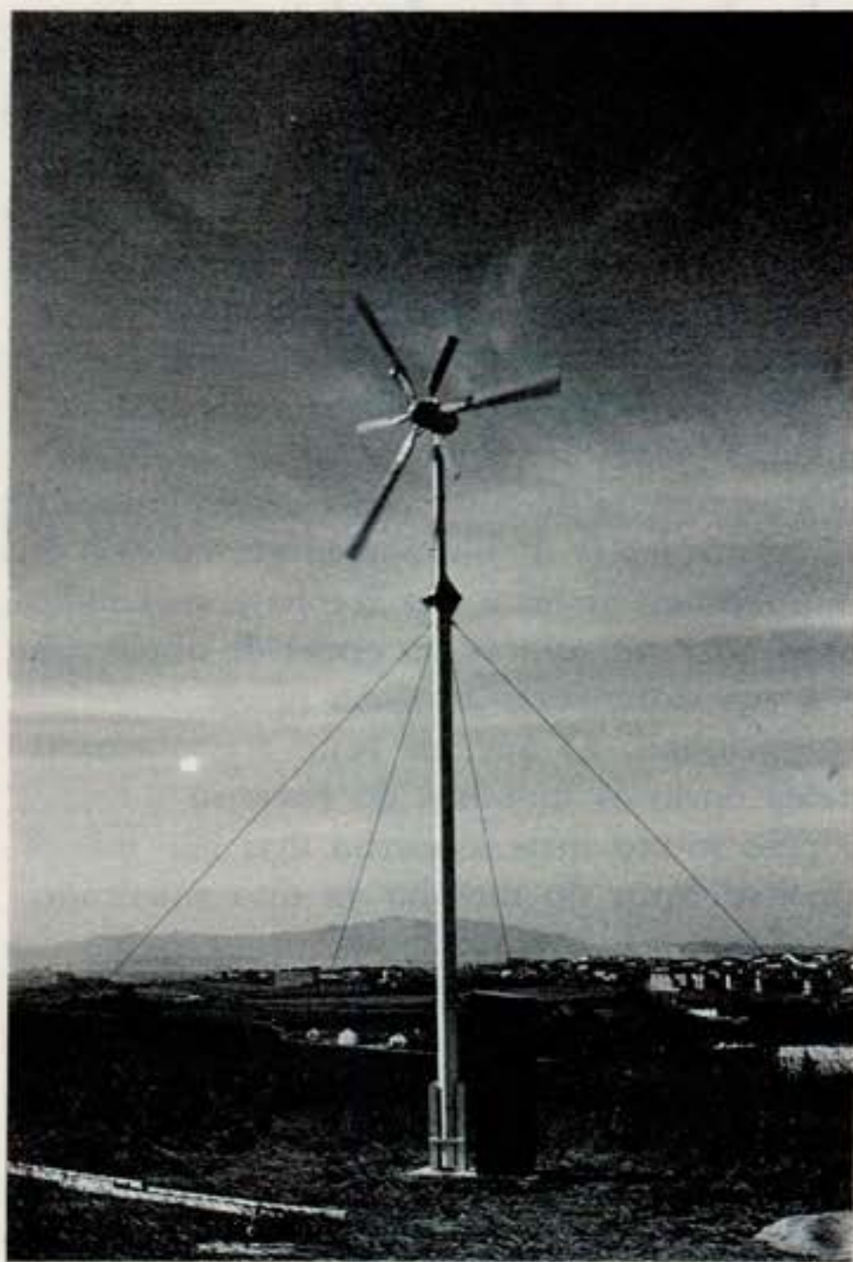
AEROGERADOR “AEROSIL 4”, CONCEBIDO E CONSTRUÍDO EM PORTUGAL PARA O FORNECIMENTO DE ENERGIA ÀS HABITAÇÕES E EXPLORAÇÕES AGRÍCOLAS ISOLADAS
