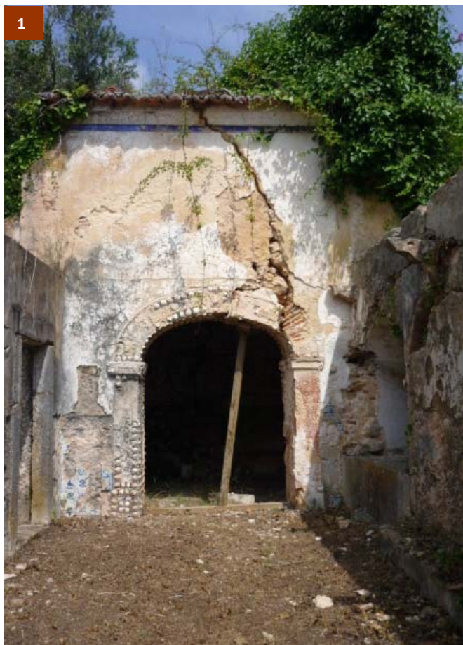
Figs. 1 : Imagem antes da intervenção Fig.2: Imagem após intervenção, onde é visível a estrutura de escoramento interior, a recolocação da peça destacada e o fecho da fractura vertical.
