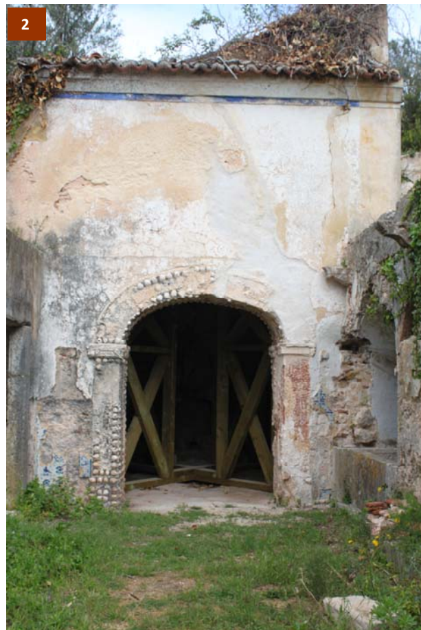
Figs. 1 : Imagem antes da intervenção Fig.2: Imagem após intervenção, onde é visível a estrutura de escoramento interior, a recolocação da peça destacada e o fecho da fractura vertical.
