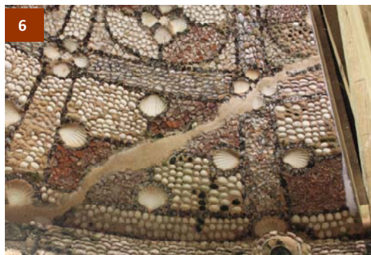
Figs.3 e Fig.4 : Imagens pelo interior da peça destacada e da fractura (antes e depois respectivamente) Fig. 5 e Fig. 6: Imagens pelo interior da fractura na cúpula da casa de fresco (antes d e depois respectivamente).
