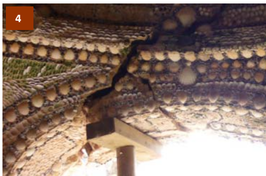
Figs. 1 : Imagem antes da intervenção Fig.2: Imagem após intervenção, onde é visível a estrutura de escoramento interior, a recolocação da peça destacada e o fecho da fractura vertical.
